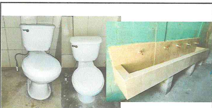
FOTO 6: SUSTITUCIÓN DE SANITARIOS Y FUNDICIÓN DE LAVAMANOS CON CINCO CHORROS
