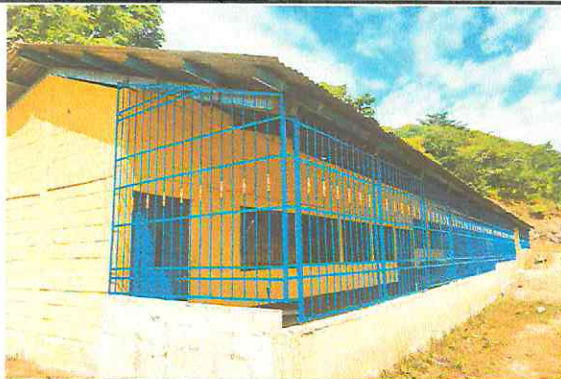
FOTO 1: SUSTITUCIÓN DE BARANDA DE METAL
