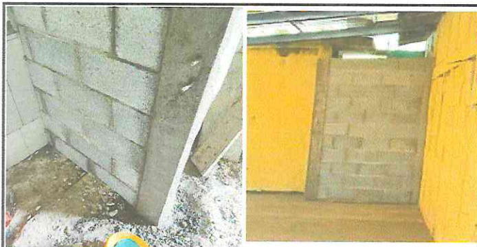
FOTO 5: LEVANTAMIENTO DE PAREDES DE BLOCK EN SERVICIOS SANITARIOS
