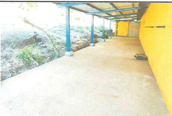
FOTO 3: FUNDICIÓN DE PISO DE CONCRETO
