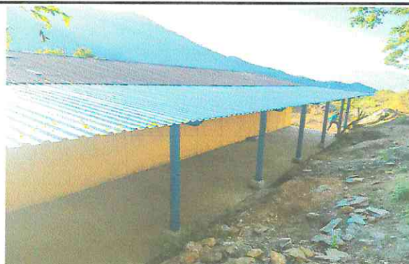
FOTO 2: INSTALACIÓN DE ESTRUCTURA DE METAL CON 6 POSTES DE COSTANERA DOBLE DE 6"X2", CARGALÁMINA DE 4" Y LÁMINA TROQUELADA
